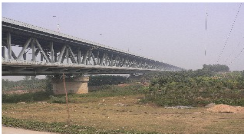
Hình 1.3- Nhịp dầm thép cầu Thăng long.
