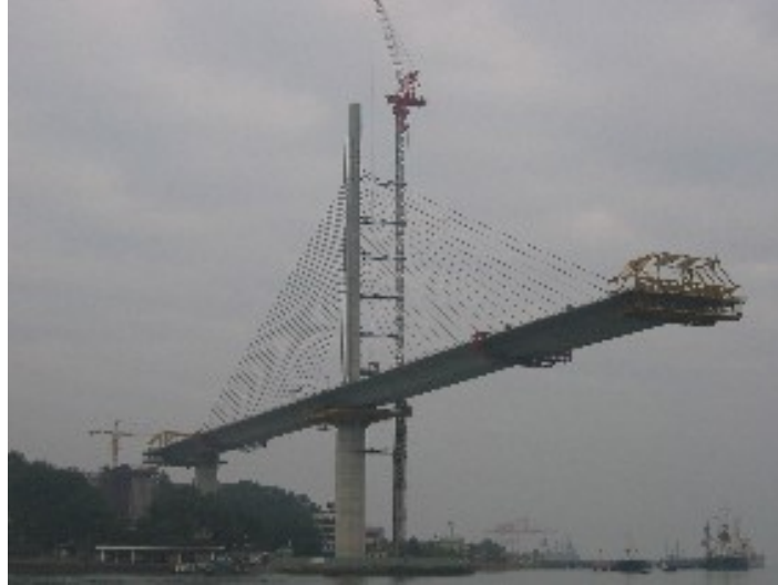
Hình 1.4- Cầu Bãi Cháy giai đoạn thi công đúc hẫng dầm cứng.
