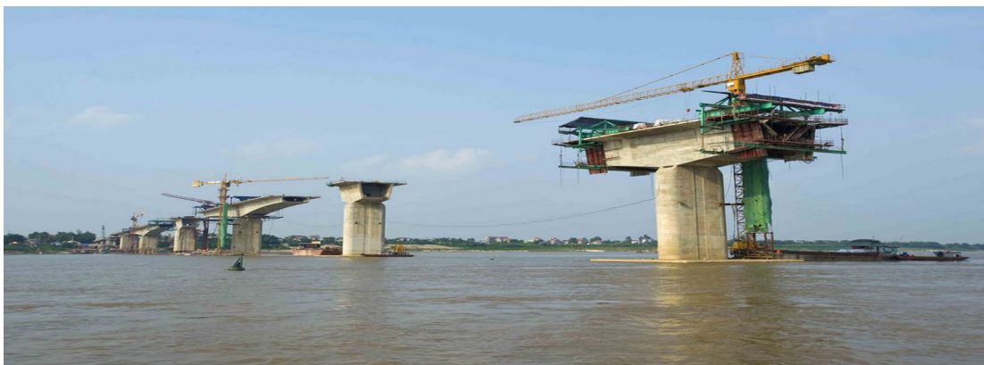
Hình 1.5- Cầu Vĩnh Thịnh giai đoạn thi công đúc hẫng cân bằng.
