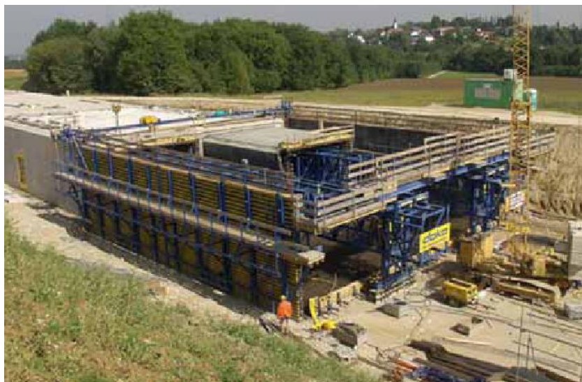
Hình 1. 103. Công tác đà giáo cho đổ bê tông khối hạ.
