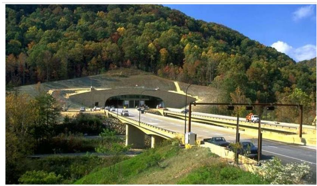
Cửa hầm đường bộ giao cầu
