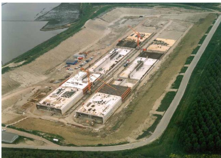
Hình 1. 102. Đổ bê tông khối hạ.
