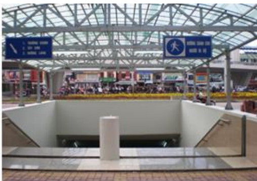
Hình 1. 51. Biển chỉ dẫn và mái che cầu thang
